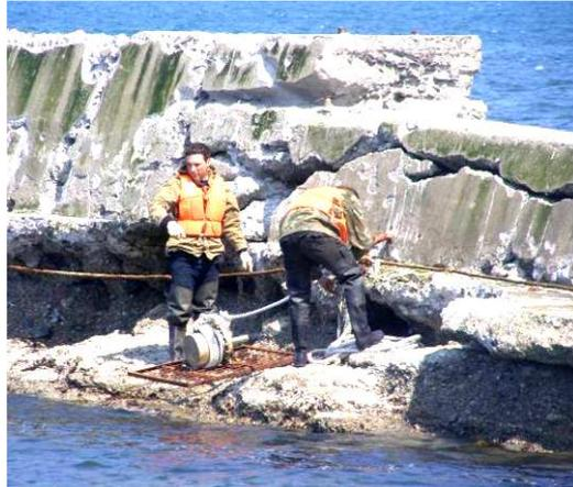
Рис. 4. Установка донного регистратора давления (волнения и уровня) в порту г. Углегорск
